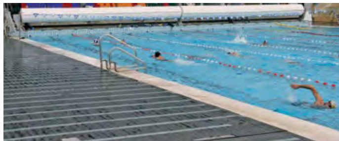
Bassin de 20 x 50 m couvert par 2 volets Abriblue à Caen
