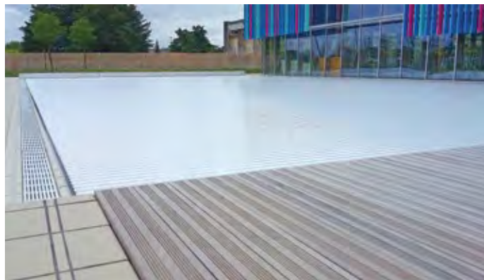
Bassin de 12,5 x 25 m à Joué-lès-Tours
